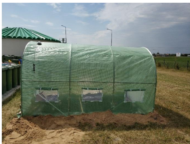
Ryc. 2. Tunel do suszenia osadu
