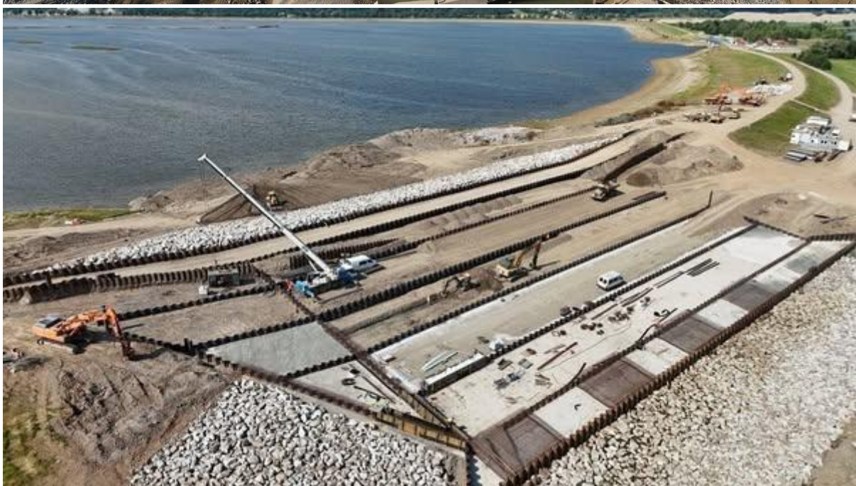
Prace przy modernizowanym przelewie powierzchniowym 5
