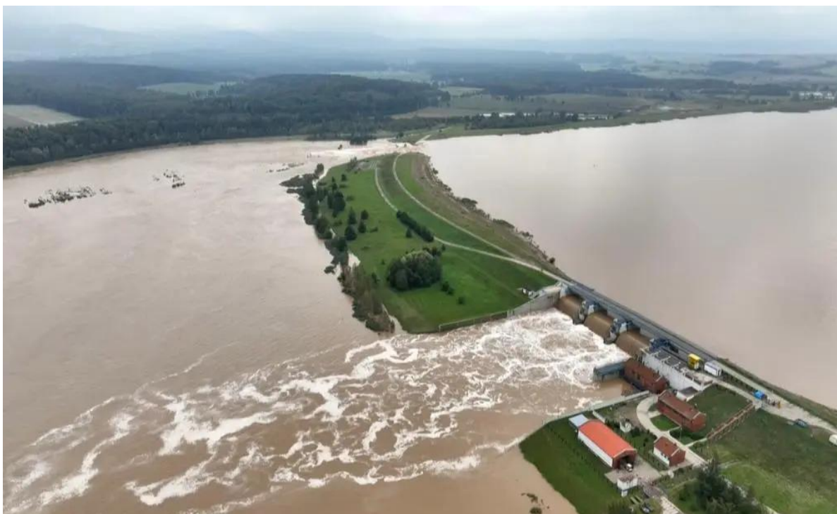
Przepuszczanie fali powodziowej przez jaz Zbiornika Topola 2
