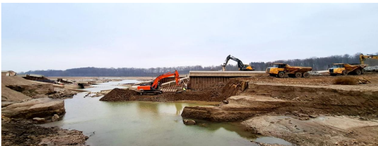
Prace przy zabezpieczeniu przelewu 4
