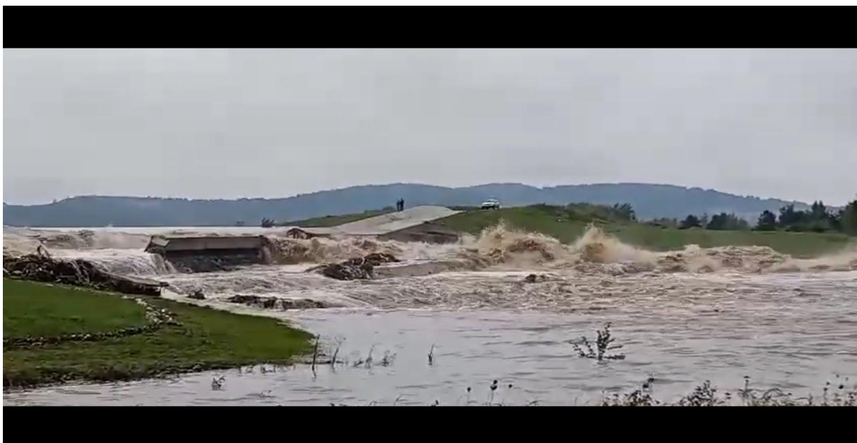
Zniszczony przelew powierzchniowy zbiornika przez powódź w 2024 r.
