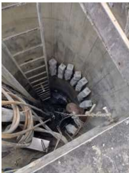
Rycina 7. Próbki betonowe w obiekcie badawczym w Grabianowie
