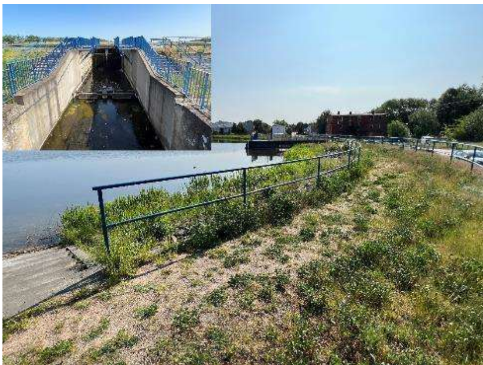
Ryc.3. Ziemna zapora czołowa wraz z budowlą upustowo-przelewową na zbiorniku Przebędowo (źródło: opracowanie własne)
