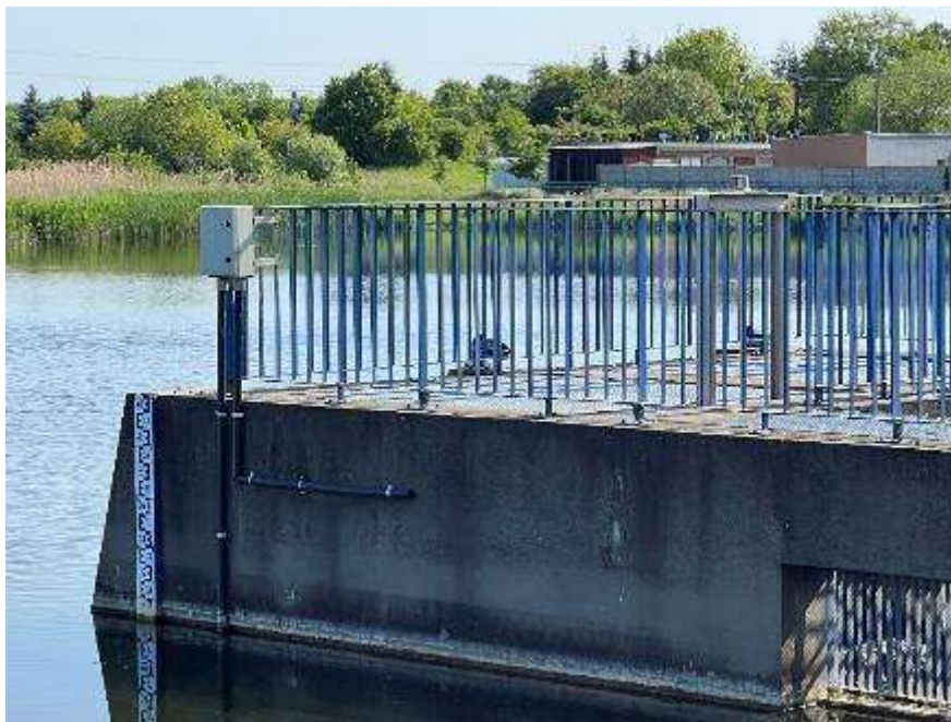
Ryc.4. Łata wodowskazowa wraz z sondą hydrostatyczną usytuowana na urządzeniu piętrzącym zlokalizowanym na odpływie ze zbiornika (źródło: opracowanie własne)
