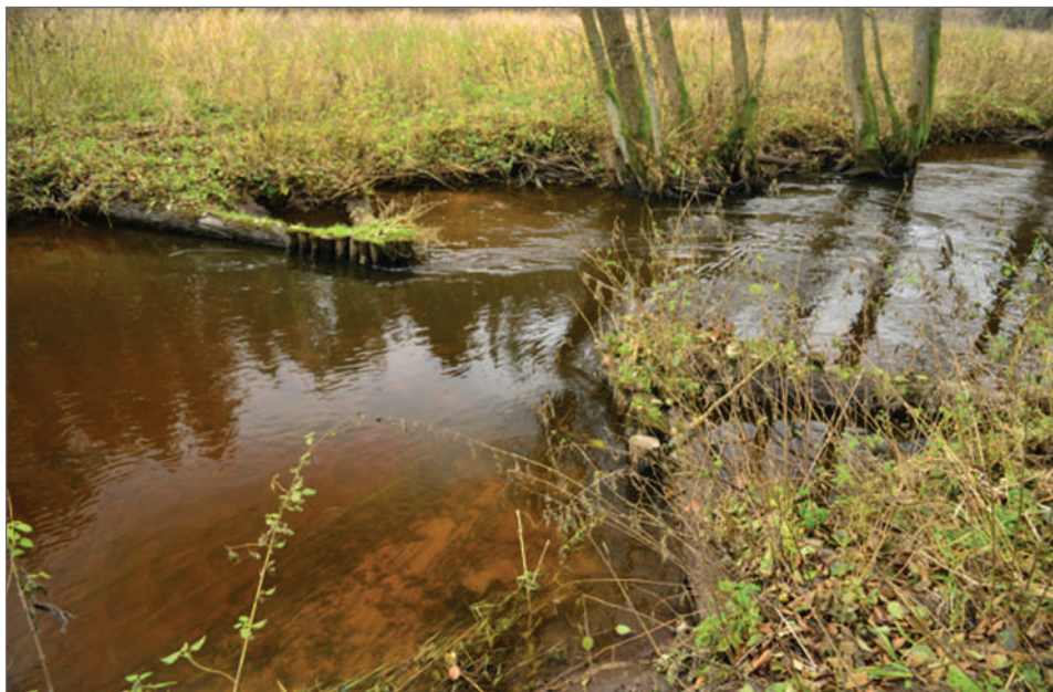
Ryc. 3. Przykład wykonanych deflektorów drewnianych zrealizowanych w ramach renaturyzacji rzeki Kwaczy (Waradzyn 2016)
