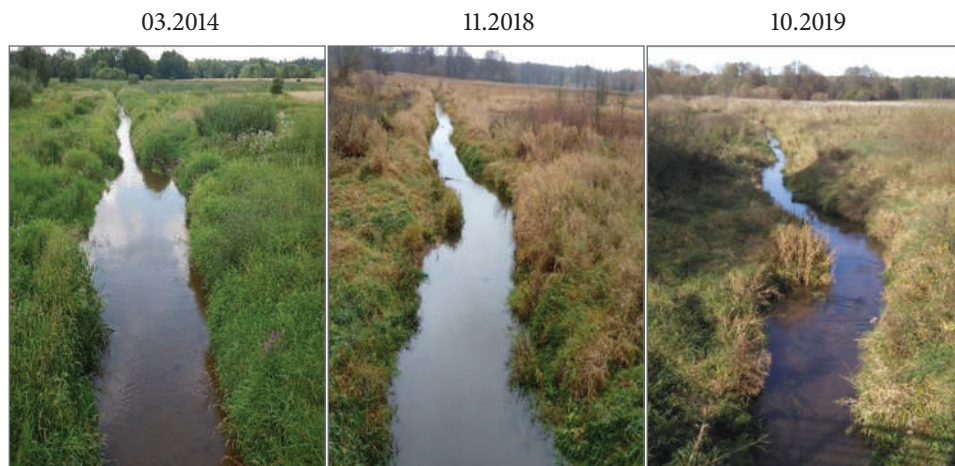
Ryc. 10. Zmiany biegu rzeki Flinty po wybudowaniu deflektorów wiklinowych: a) 2014 – sytuacja przed wybudowaniem, b) 2018 w roku zainstalowania deflektorów i c) sytuacja po rocznym oddziaływaniu konstrukcji; fot. Autorów
