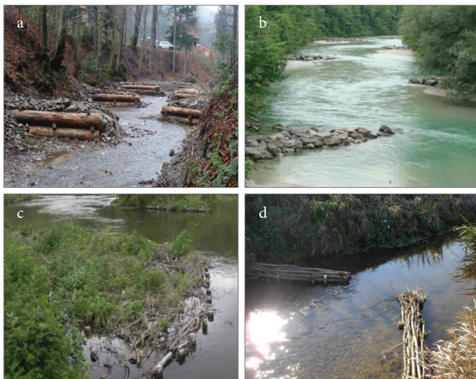
Ryc. 5. Przykłady różnych rozwiązań konstrukcyjnych deflektorów, a) zabudowa deflektorami z kłód drewnianych i narzutu kamiennego koryta potoku górskiego Roztoka Mała (PGW 2018), b) system deflektorów kamiennych na rzece górskiej Königsseer Ache, Austria (Radzicki 2016), c) deflektor wiklinowy w kształcie litery D na rzece nizinnej Skerne UK (Stream 2009), d) deflektor z kieszki faszynowej – rzeka nizinna Welland UK (Ecologylink 2020)
